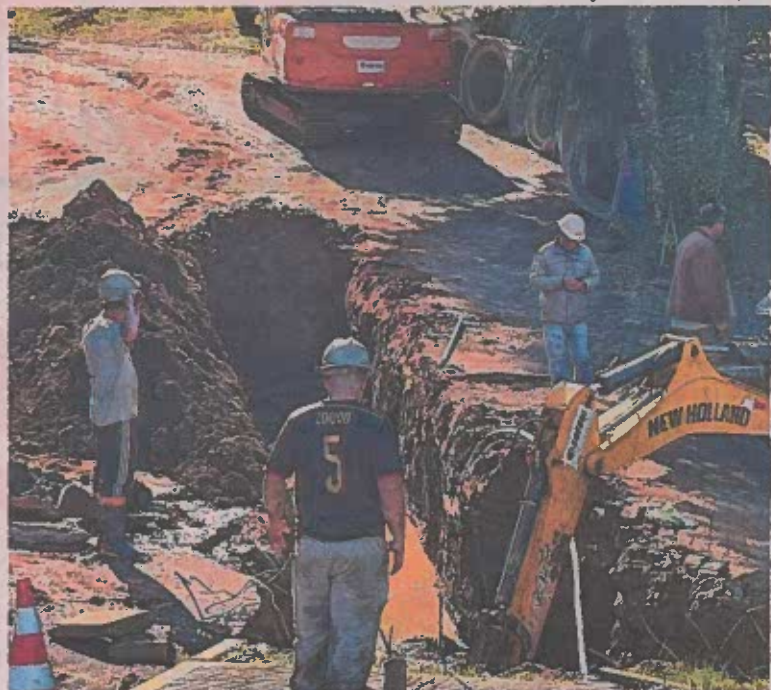
Rua Bento Gonçalves: nova rede pluvial para garantir escoamento da água da chuva
